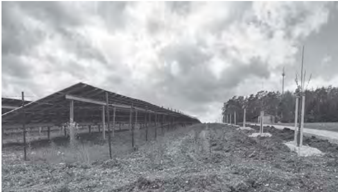
Streuobstwiese im Norden des Solarparks Poxstall Stadtwerke Ebermannstadt GmbH
