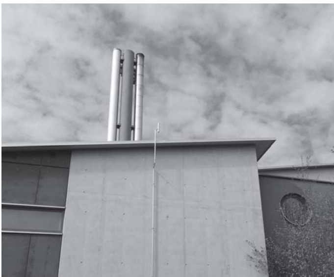
Biomasseheizwerk am Hasenberg
